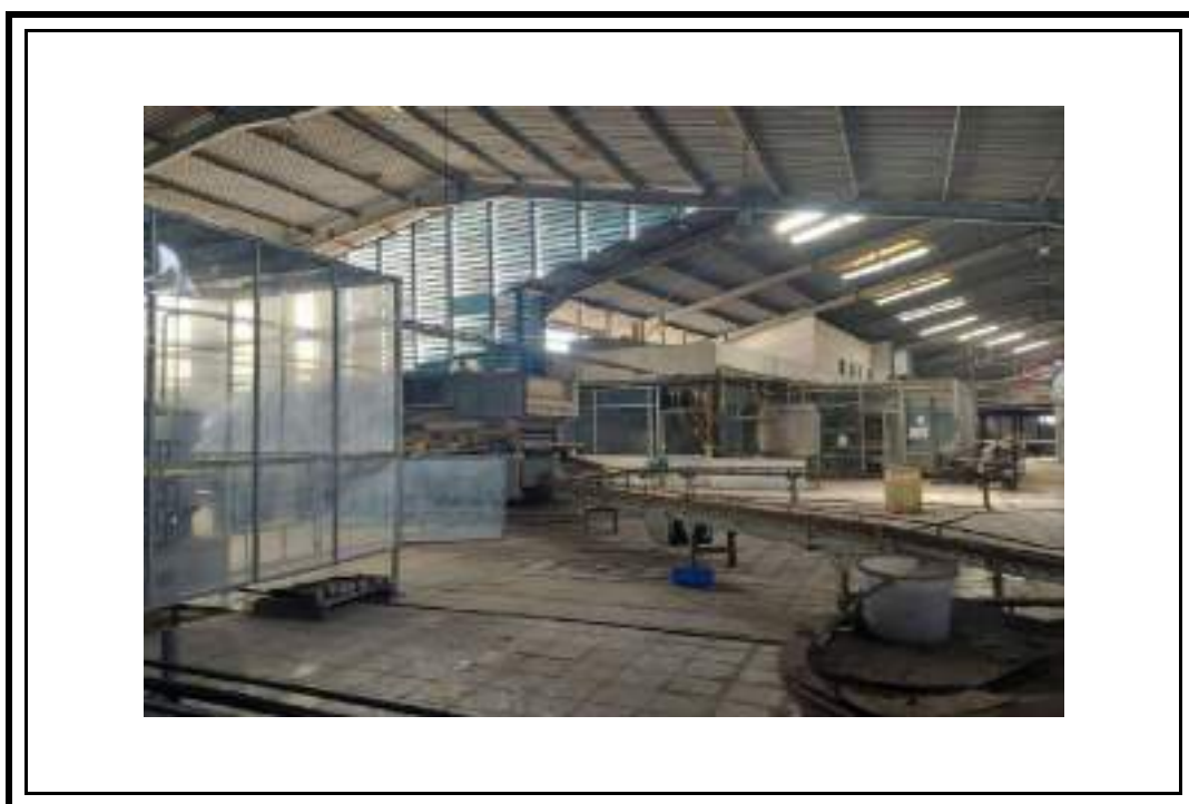
Tampak Dalam Bangunan Pabrik dan Gudang 2
