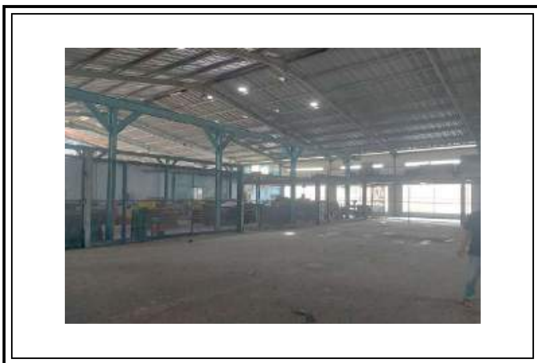
Tampak Dalam Bangunan Pabrik dan Gudang 3
