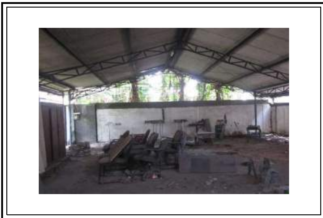
Tampak Dalam Bangunan Gudang Repack
