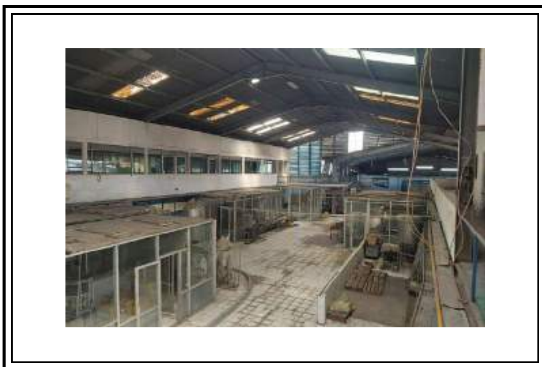
Tampak Dalam Bangunan Pabrik dan Gudang 2
