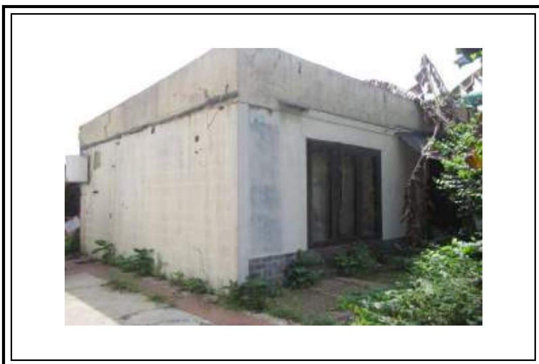
Tampak Depan Bangunan Mess
