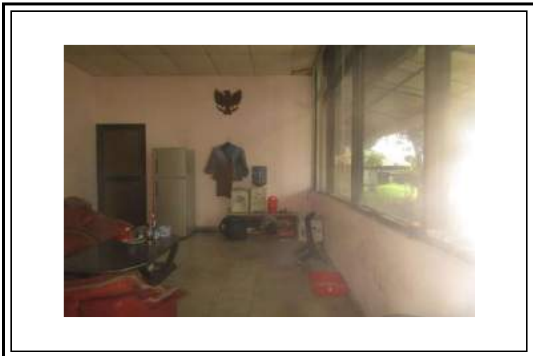
Tampak Dalam Bangunan Pabrik dan Gudang 2 (Lantai 1)
