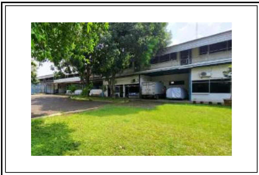
Tampak Bangunan Pabrik dan Gudang
