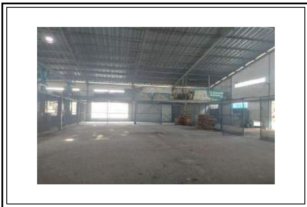
Tampak Dalam Bangunan Pabrik dan Gudang 3
