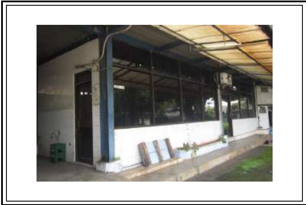
Tampak Bangunan Pabrik dan Gudang 2 (Lantai 1)
