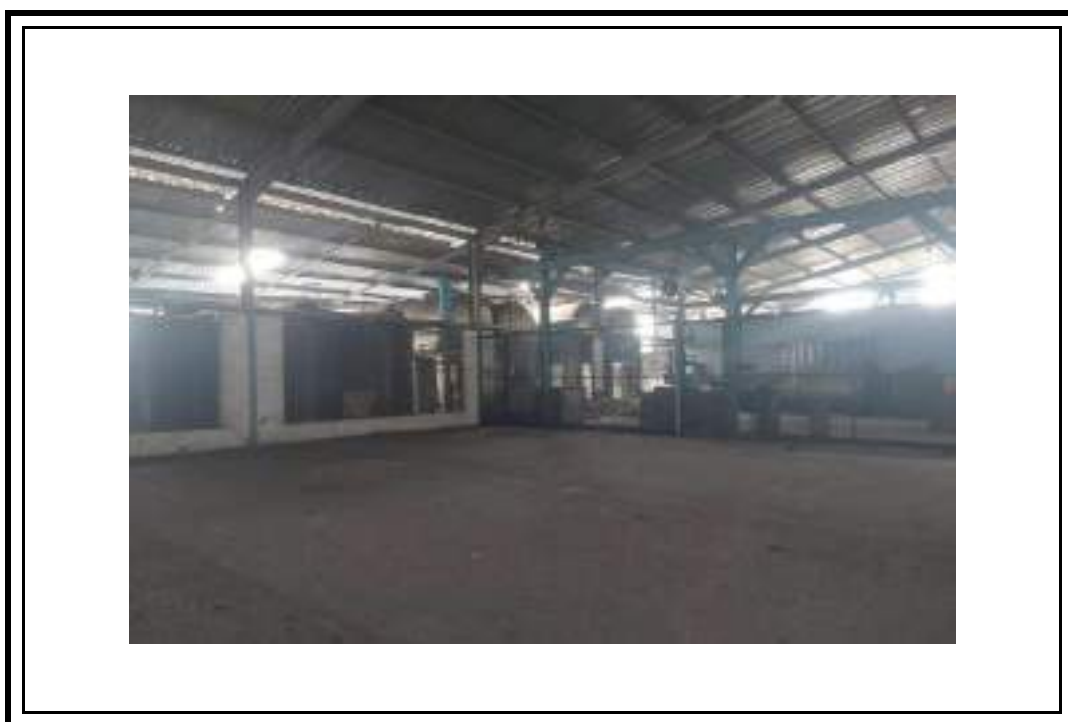
Tampak Dalam Bangunan Pabrik dan Gudang 3
