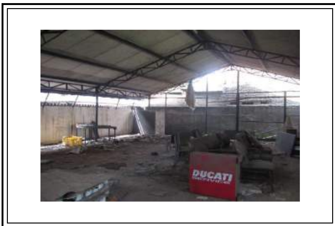
Tampak Dalam Bangunan Gudang Repack
