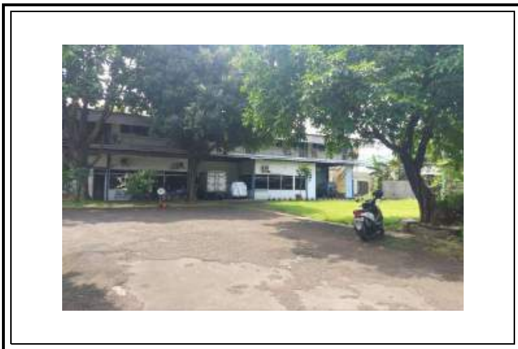
Tampak Bangunan Pabrik Dan Gudang 1
