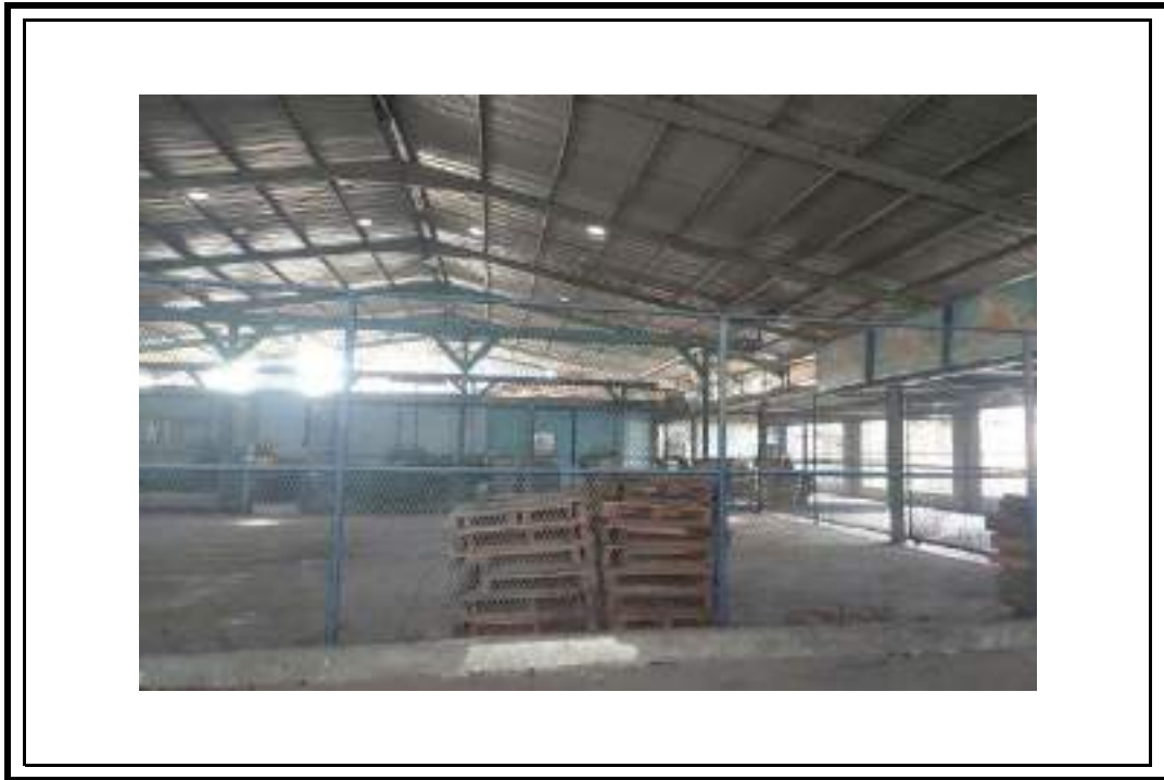
Tampak Dalam Bangunan Pabrik dan Gudang 3
