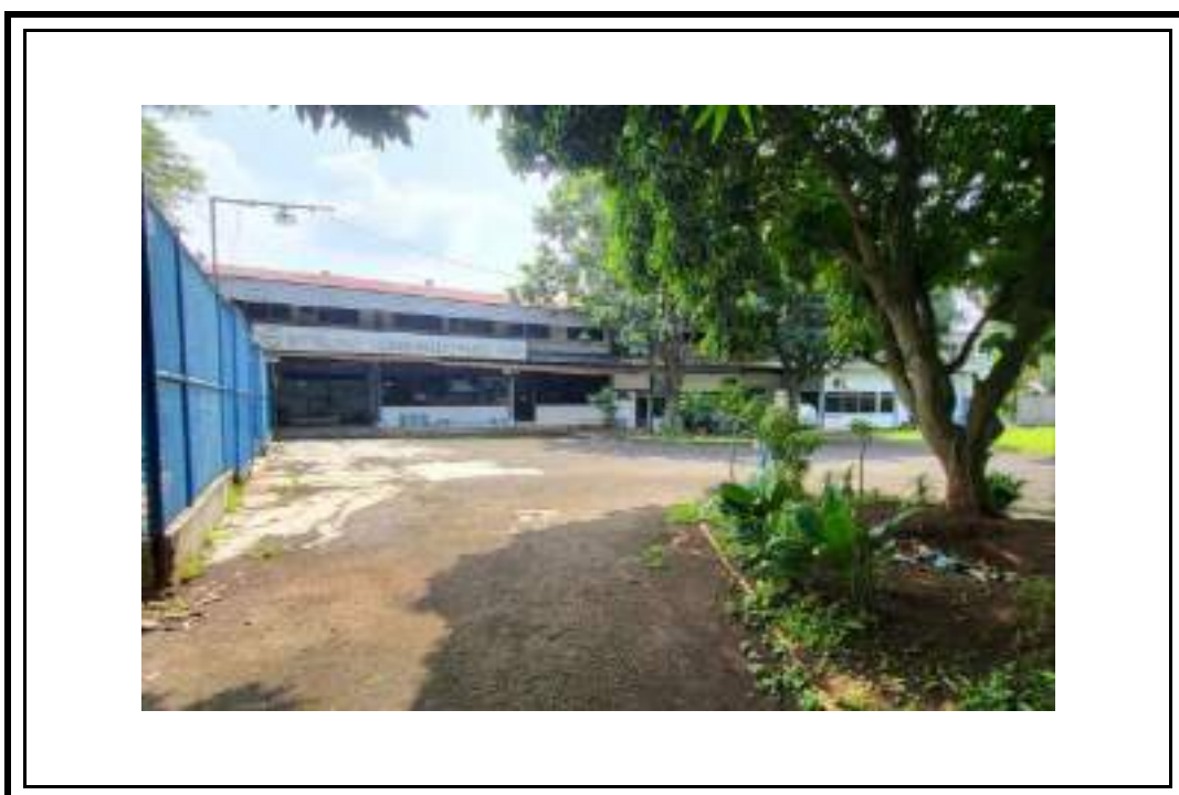
Tampak Bangunan Pabrik dan Gudang
