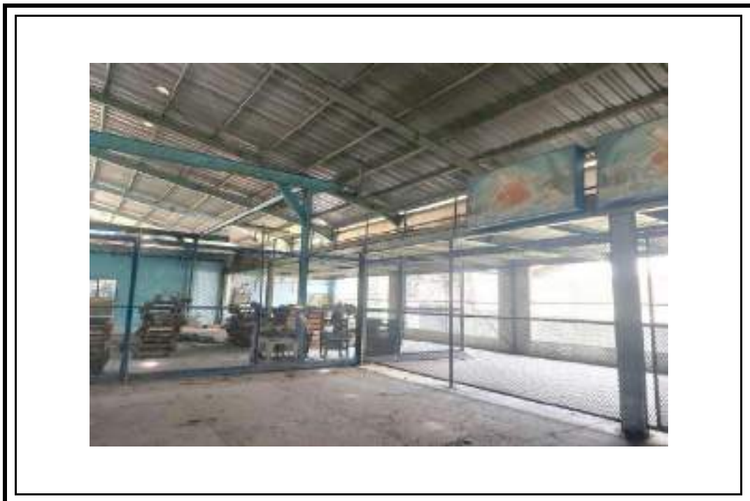
Tampak Dalam Bangunan Pabrik dan Gudang 3 (Lantai Tambahan/Mezanine)
