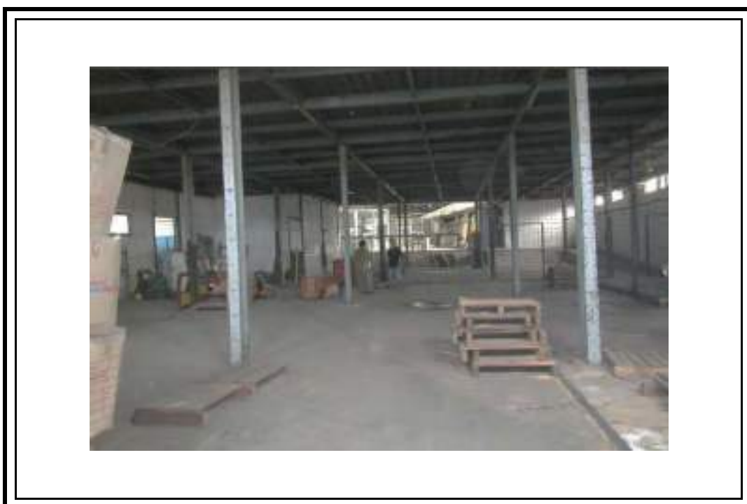
Tampak Dalam Bangunan Pabrik dan Gudang 1 (Lantai 1)
