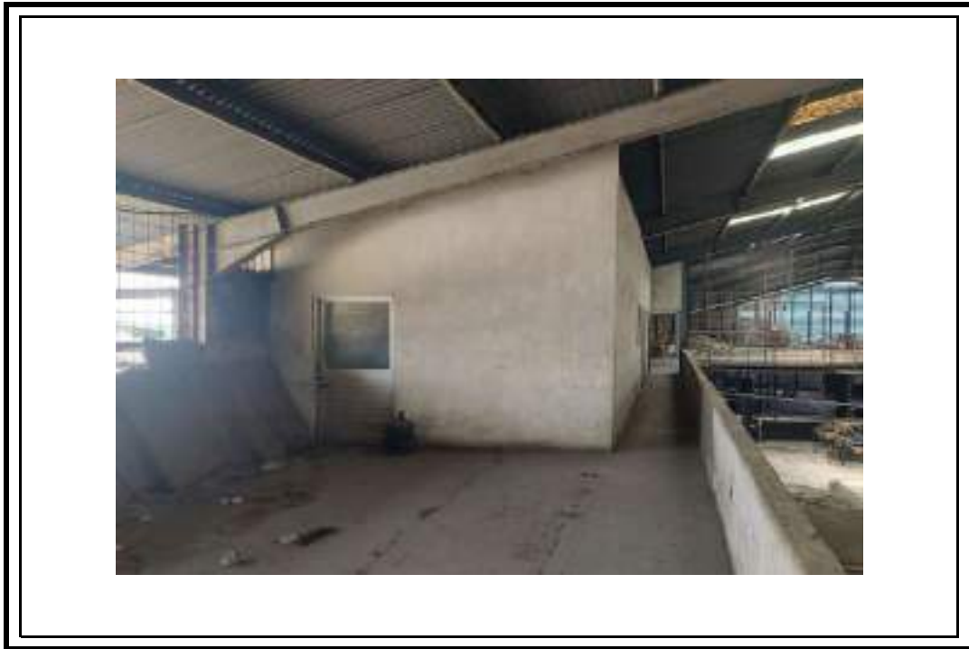
Tampak Dalam Bangunan Pabrik dan Gudang 2 (Lantai Tambahan/Mezanine)
