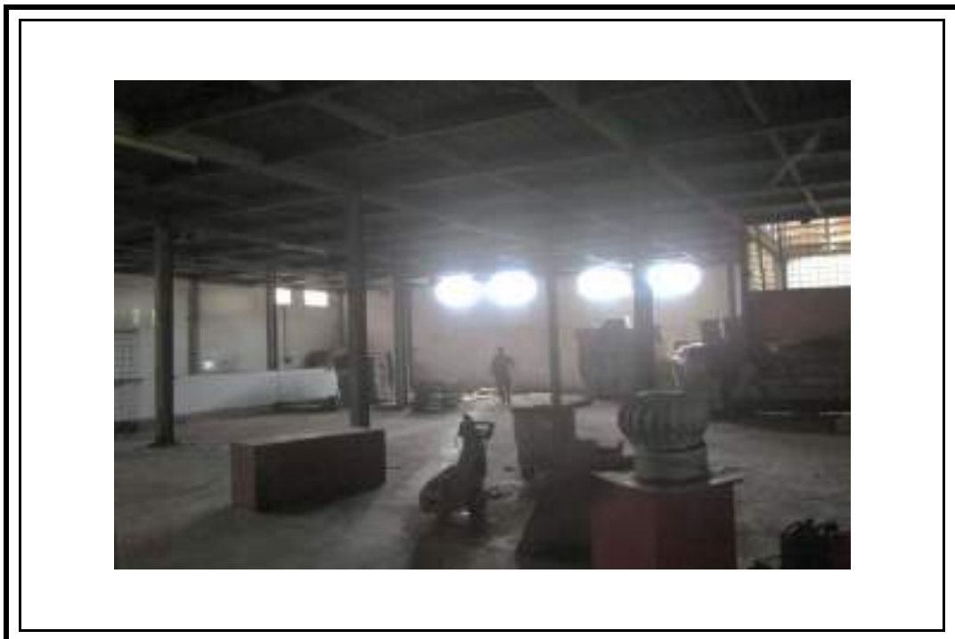
Tampak Dalam Bangunan Pabrik dan Gudang 1 (Lantai 1)
