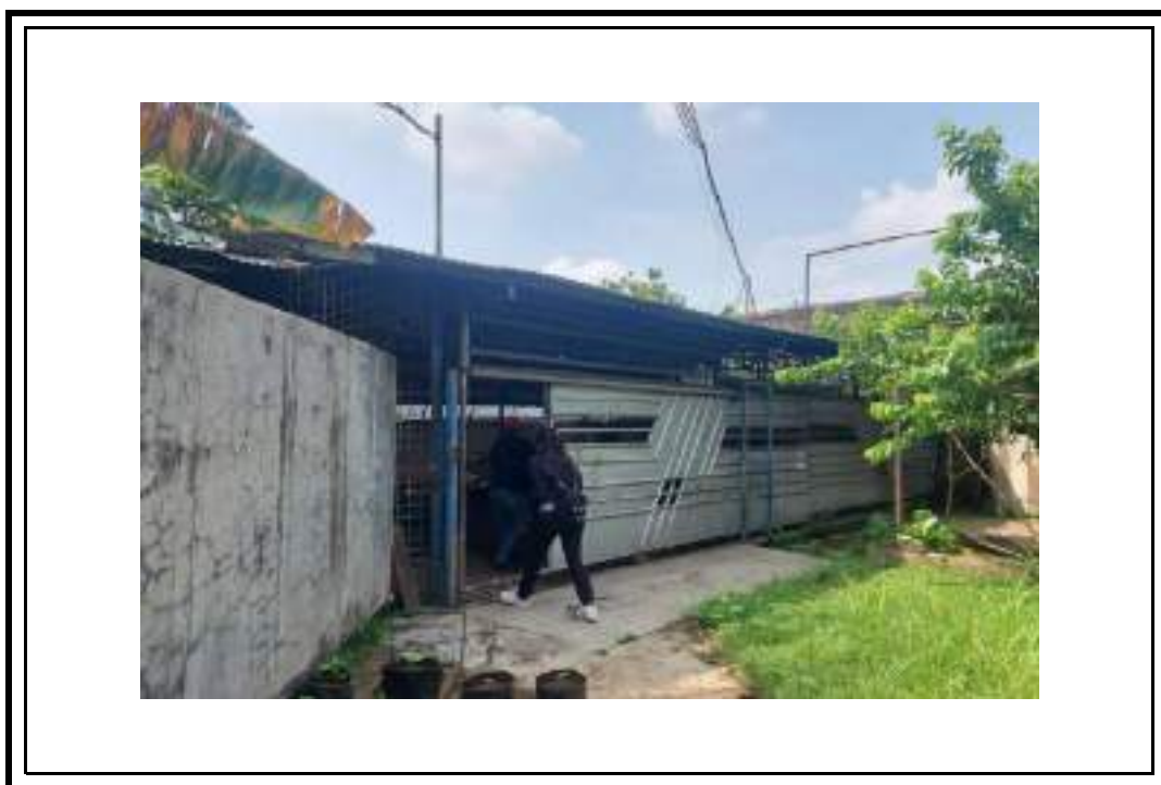
Tampak Depan Bangunan Gudang Repack
